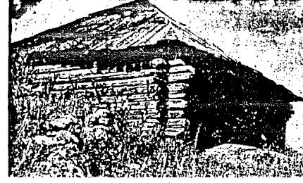
Şekil 35 — Ankarada Kızılca Hamam civarında bir çanti ev
