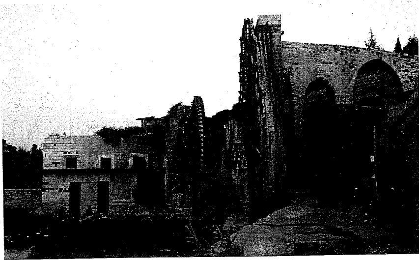
Res.18- Hama'da bulunan Davaalik ve Hudura Nauraları ve değirmen binası. (Batıdan)
