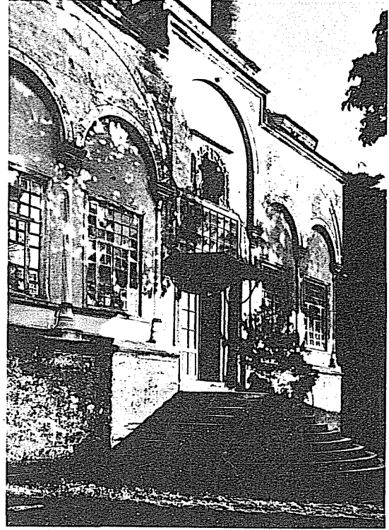
RESİM: 10 Ayazma Camii kuzey cephesi - 1939
